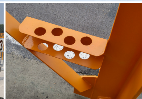
마스트 핀 거치대 적용으로 설치 편의성 증대
